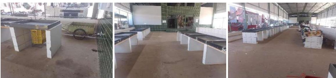
Figura 20, 21 e 22 - Situação atual de bancadas, onde terá o fechamento da parte frontal com alvenaria e acabamento cerâmico.
