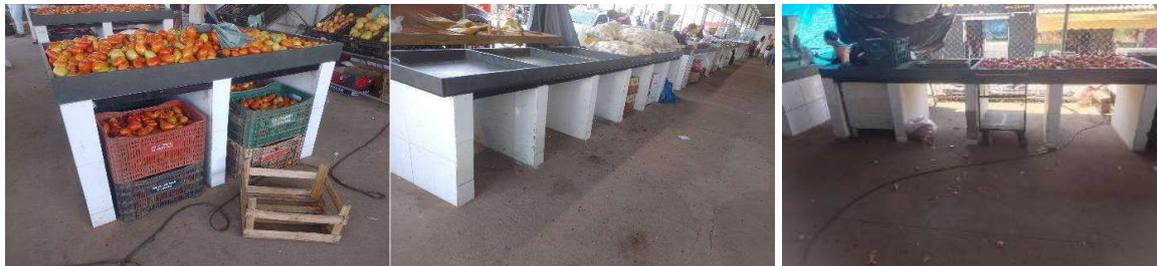
Figura 17, 18 e 19 - Situação atual de bancadas, onde terá o fechamento da parte frontal com alvenaria e acabamento cerâmico.
