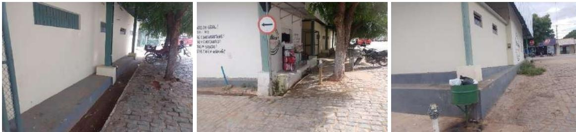
Figura 45, 46 e 47 – Será feiro uma rede externa para coletar os esgotos vindo das caixas de gordura até a fossa;
